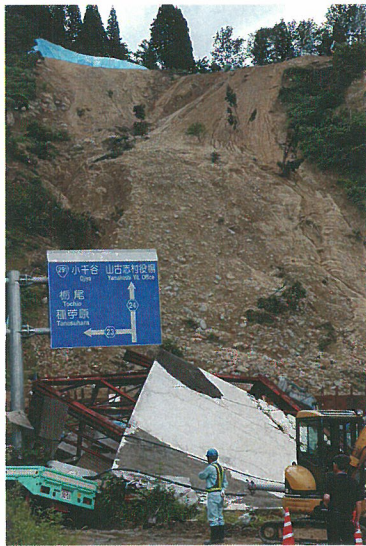
土石流で通行不能の道路
