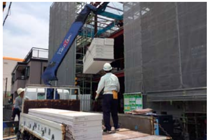
6月22日。ALCパネル（高温高圧蒸気養生された軽量気泡コンクリート）の搬入が始まりました。外壁工事が本格化します。
